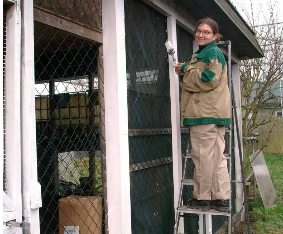
In den kalten Wintermonaten findet sich endlich die Zeit, Renovierungsarbeiten anzugehen.
