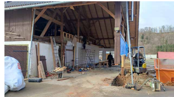
Die alte Schau-Brennerei sowie die Garagen wurden abgerissen.
