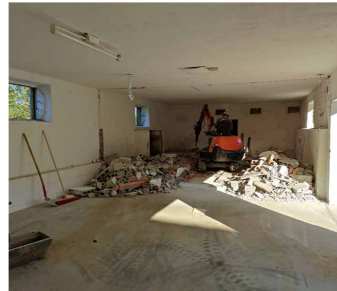
Vor dem Umbau zum Pferdestall musste entkernt werden.
